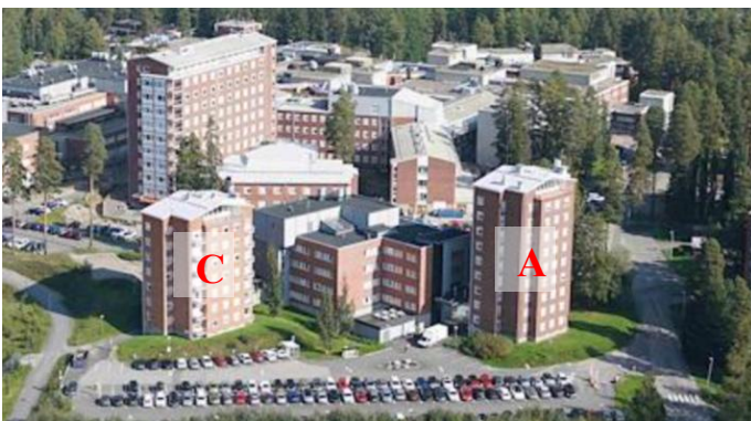
Kuva: Suunnittelualueen rakennukset, Kukkumäentie 28 A (ent. sairaalan rak. nro 5) ja C (ent. sairaalan rak. nro 4)
